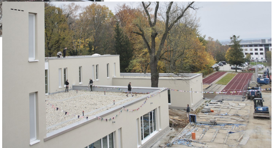
Rechts: Blick auf das Neubaudach und auf die noch vorhandene Baustelle
